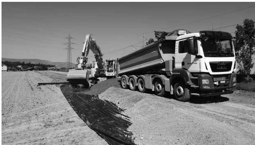
Schütten Baupiste nach Hambüelwald Grafenried
